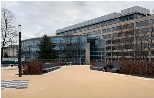
Außenbereich Wilhelm-Dörpfeld-Gymnasium © WES LandschaftsArchitektur
